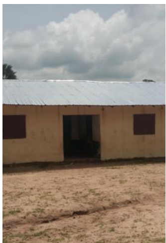
De donkere container is nu een mooi schoolgebouw geworden
